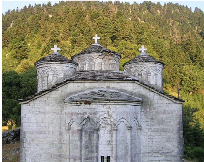
Η στέγη πριν τις εργασίες
