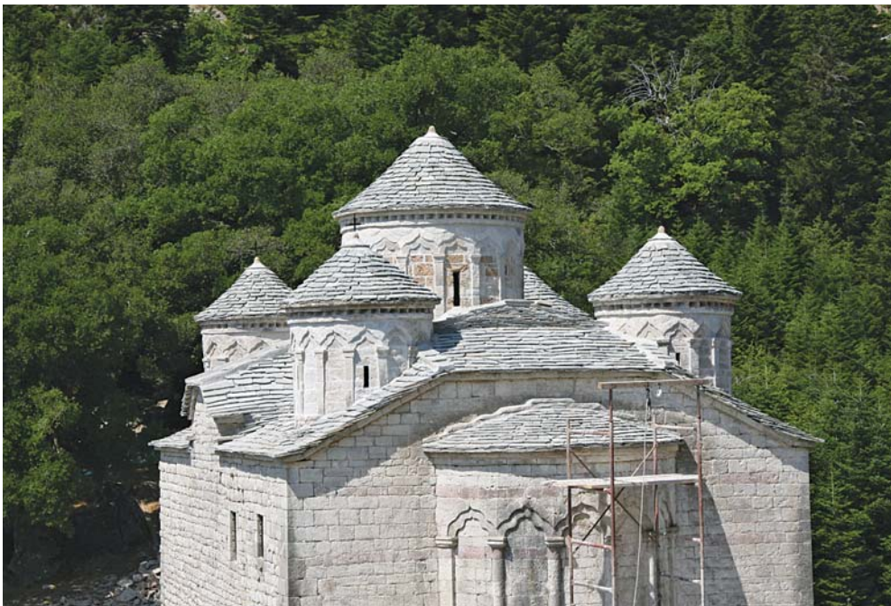
Η στέγη του Ναού μετά τις εργασίες, Καλοκαίρι 2011
