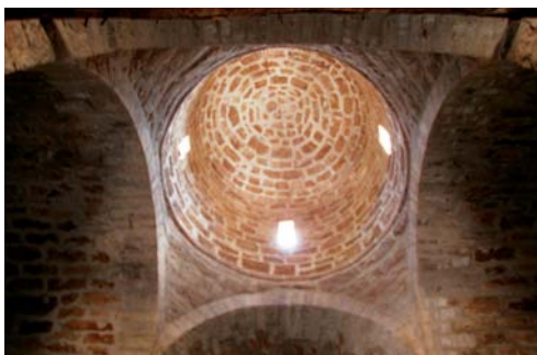
Το εσωτερικό των τρούλων μετά
