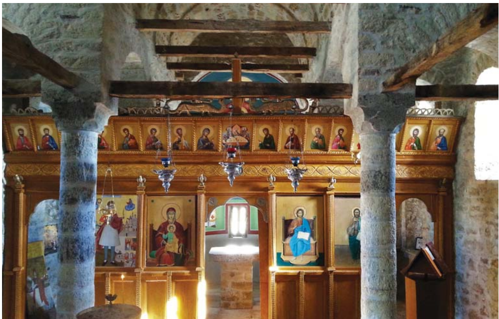
Τέμπλο του Ναού, οι πέτρινοι κίονες με τα κιονόκρανα και οι ξύλινοι συνδετήρες
