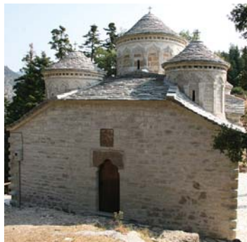
Δυτική πλευρά μετά
